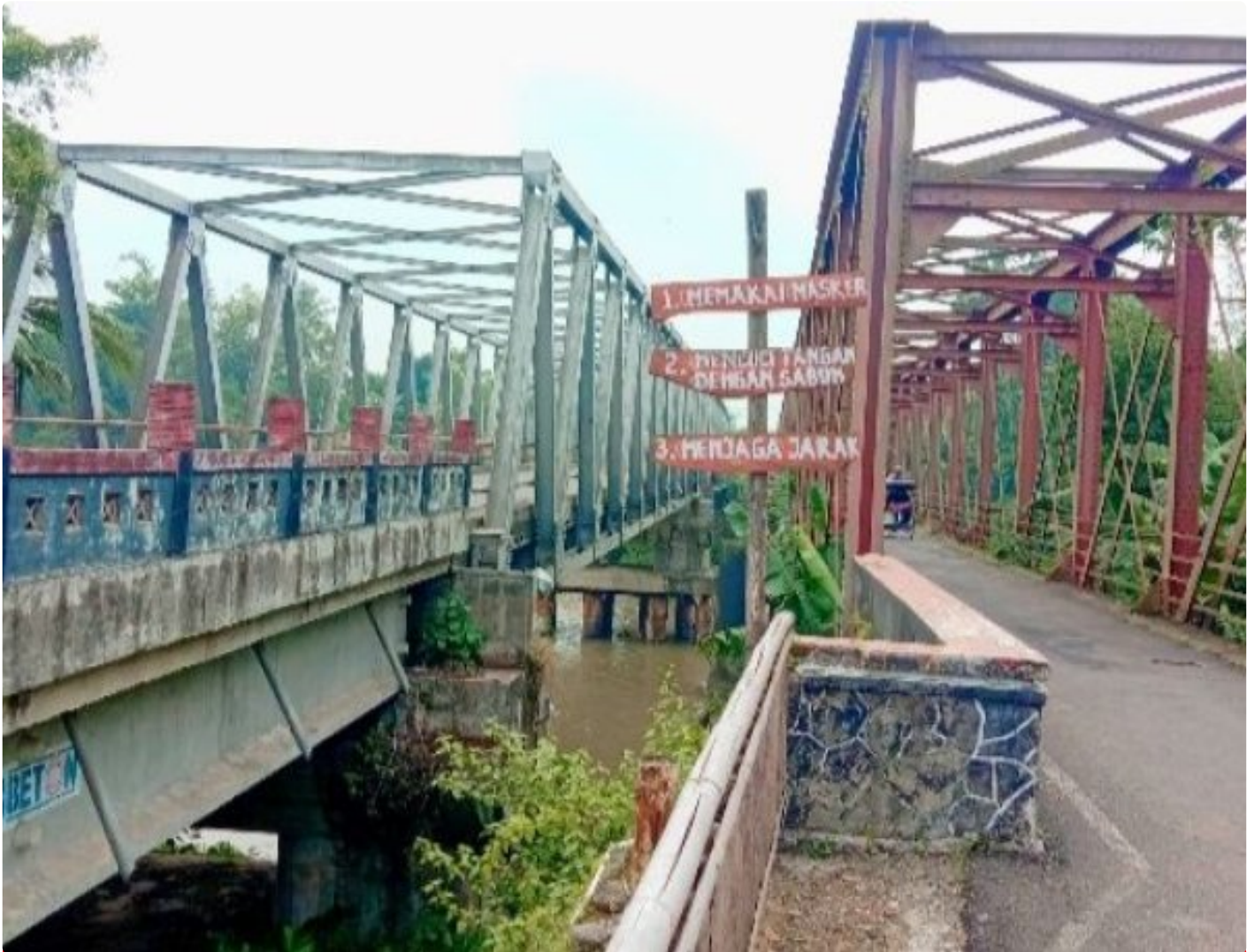
Dua Jembatan di Patikraja, Jembatan Merah Patikraja Dan Jembatan Baru
